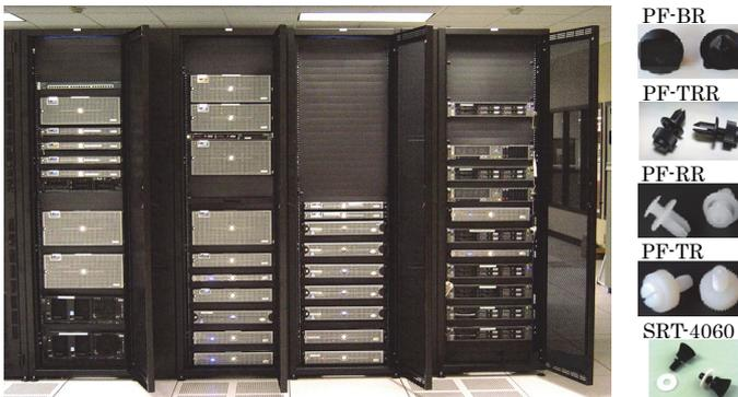
実際の設置例、EIA 310-E規格の19インチラック全てに対応します。
